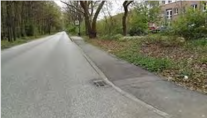
An den Schießständen - vor dem Umbau
