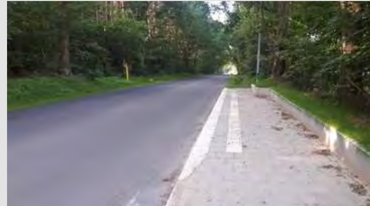
An den Schießständen - nach dem Umbau
