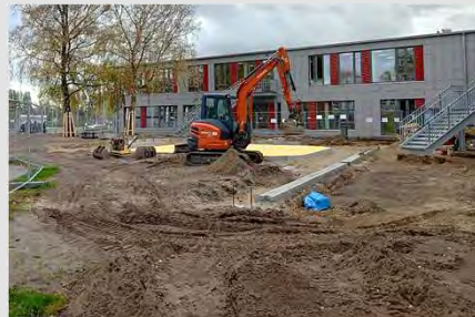
Baggerarbeiten auf dem Schulhof
